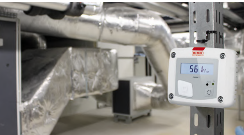
CO2ST, montiert in der Lüftungsanlage einer industriellen Infrastruktur.
