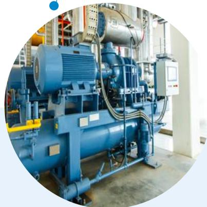
Inbetriebnahme oder Wartung einer Kälteanlage, Überprüfung des Kühlkreislaufs auf Dichtigkeit, Befüllen mit Gas und gleichzeitige Kontrolle des Differenzdrucks und der Unterkühlungs-/Überhitzungstemperaturen.
